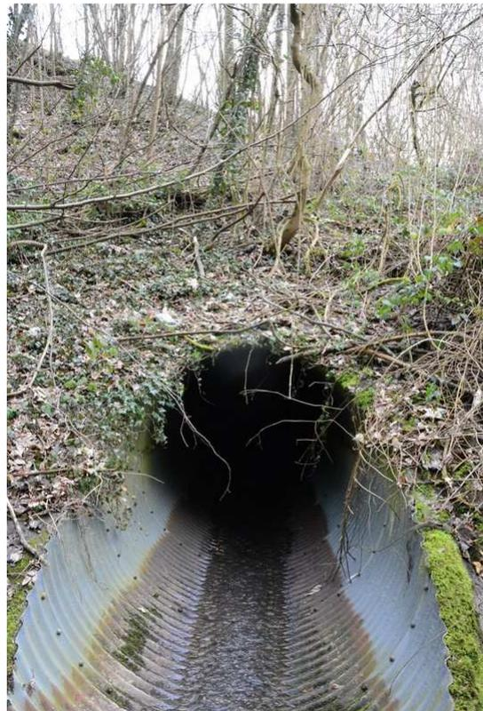
Le passage sous la D21. L'eau coule sur une tôle rouillée qui se disloque par endroits.
