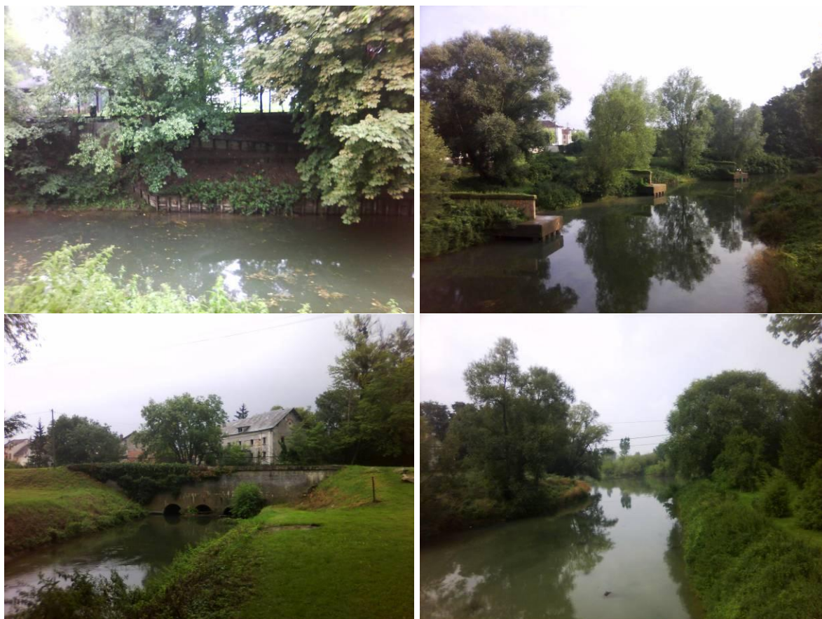
Figure 93 : Confluence du bras droit, un secteur très aménagé
