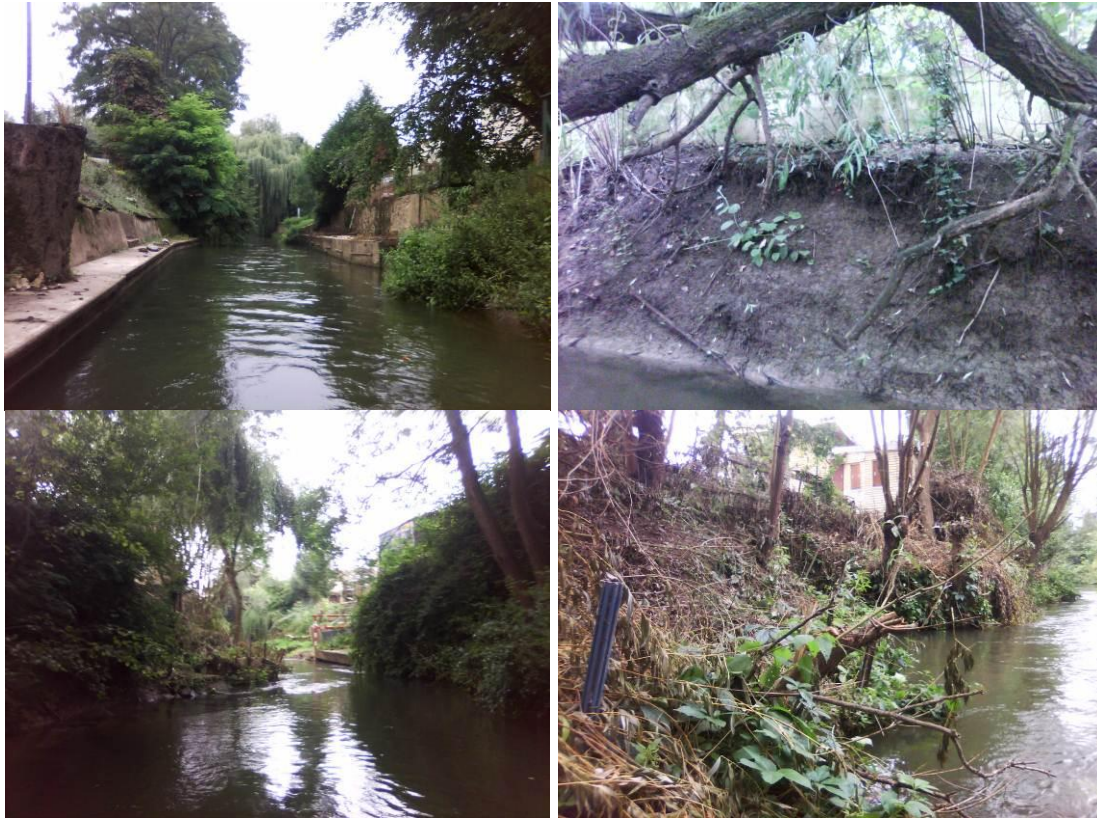
Figure 92 : Confluence du bras gauche, un secteur dynamique
