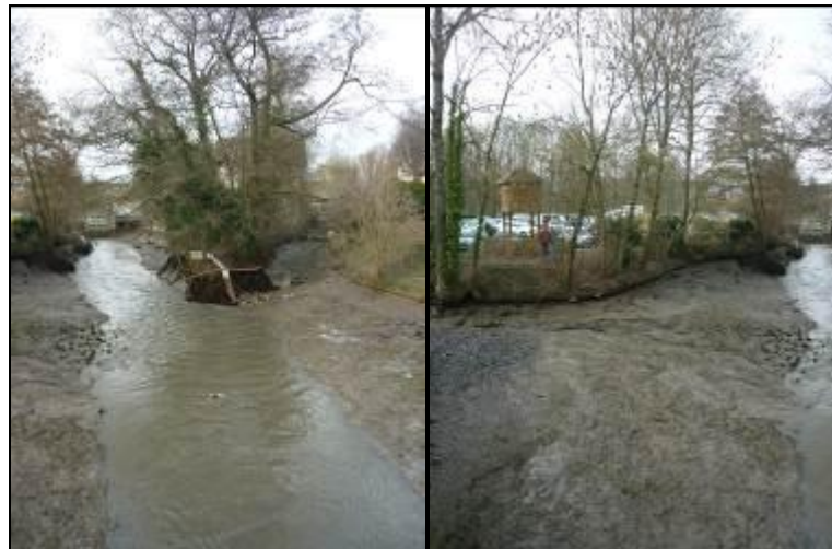
Photo 15 : Moulin de l'Arche ouvert et déconnexion des brassets amont
