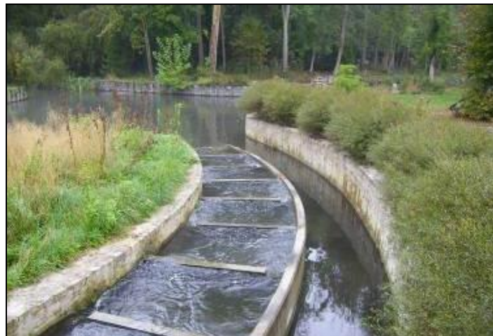
Photo 3 : Exemple d'une passe à bassins et d'une passe à canoë-kayak sur l'Essonne
