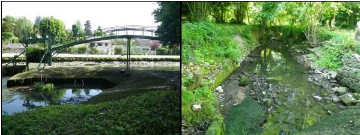
Photo 12 : Vannage principal de Quintejoie ouvert, perte d'alimentation du réseau en rive droite
