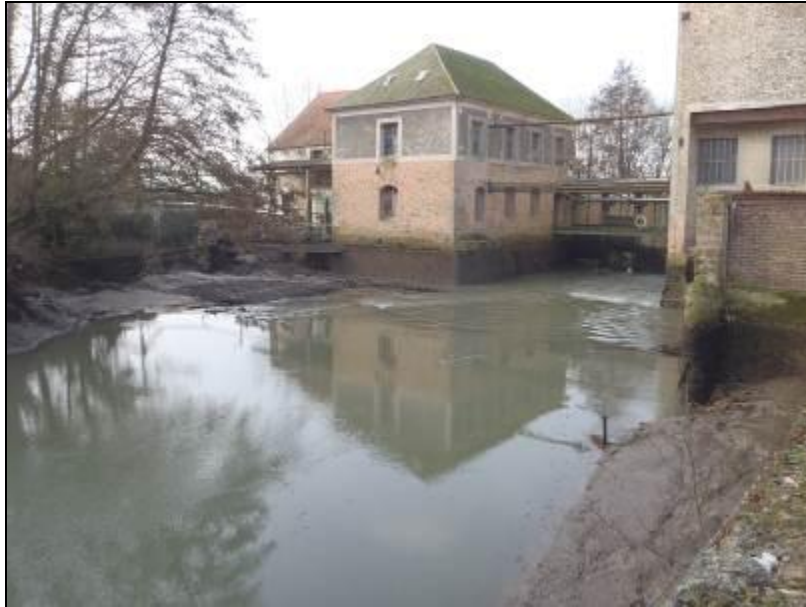
Photo 4 : Ouvrages de l'usine de Boissy-le-Châtel – déversoir D1 à gauche
