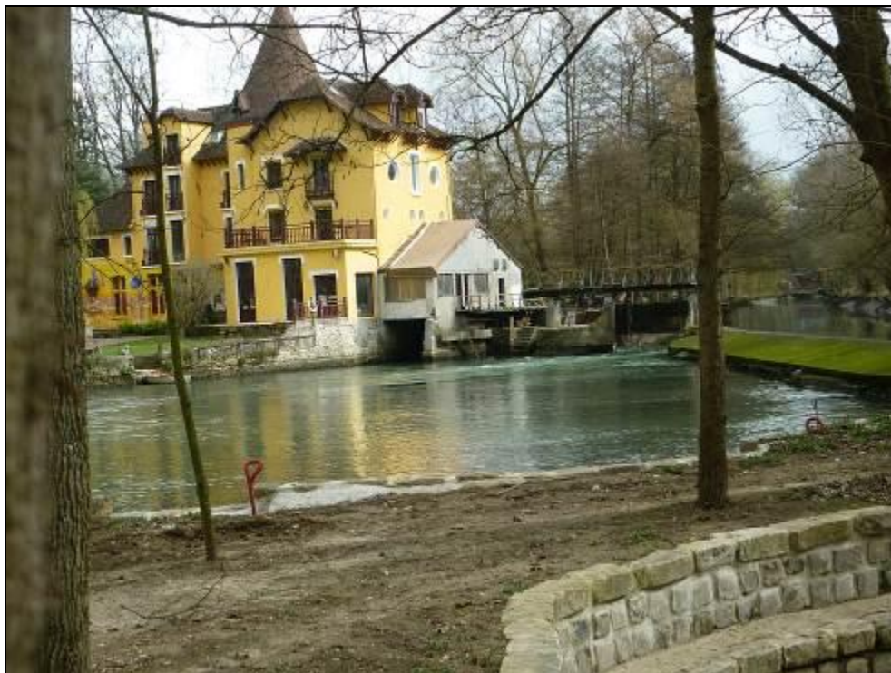
Photo 8 : Ouvrages de Moulin Nicol (moulin Jaune) ouverts
