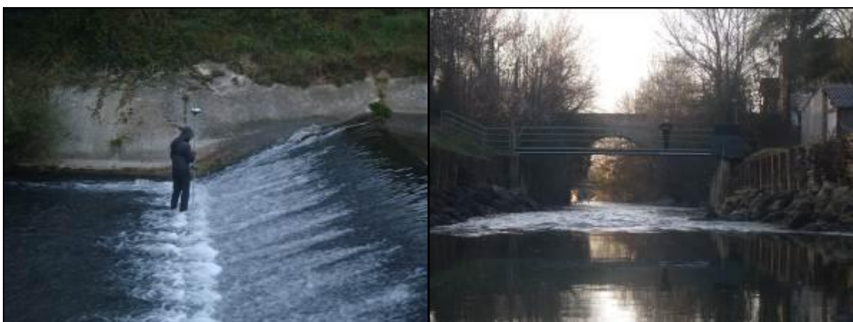
Photo 14 : Ouvrages Fausse Rivière : seuil et clapet ouvert
