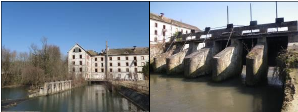
Photo 16 : Moulin des Prés niveau régulé et ouvert
