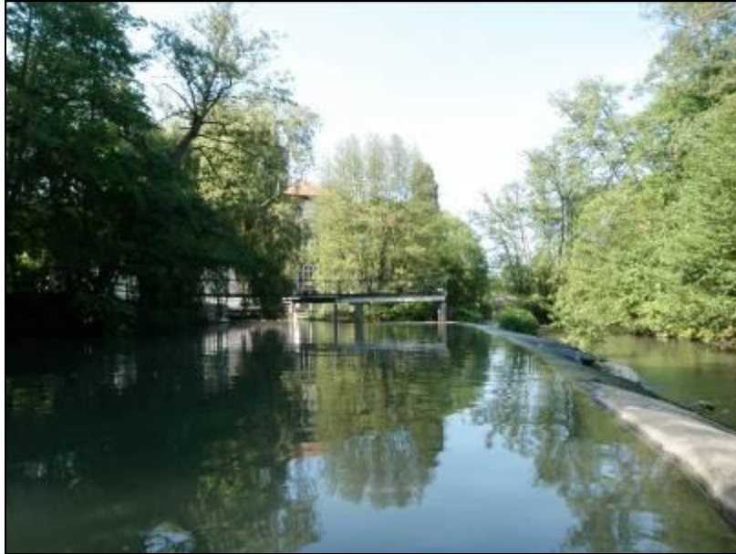
Photo 7 : Ouvrages du moulin de Tigeaux
