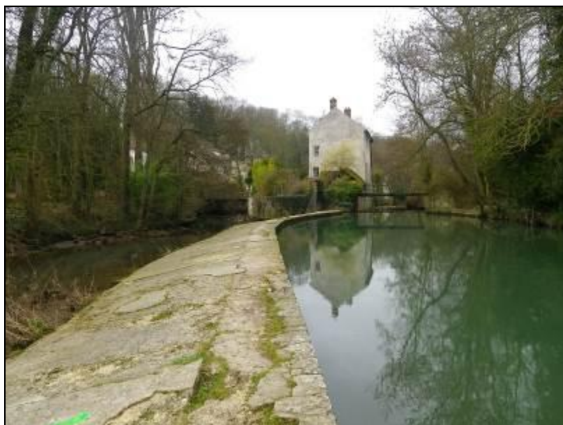
Photo 18 : Barrage du Faubourg (ou Moulin Saint-Martin)
