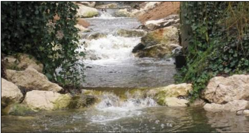
Photo 1 : Succession de 3 prébarrages seuil de la Milonière (Vigneray) - source : SAGYRC, syndicat du bassin de l'Yzeron
