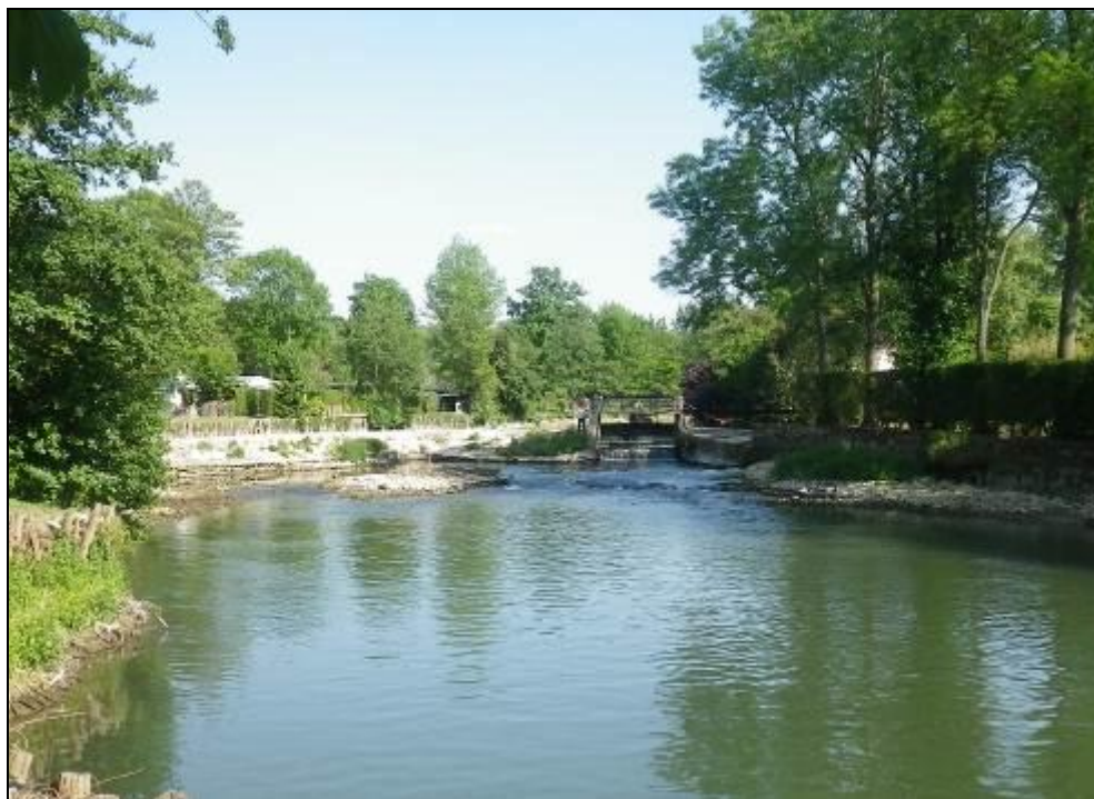
Photo 9 : Vue aval du complexe Guillaume/Martigny, ouvrages ouverts
