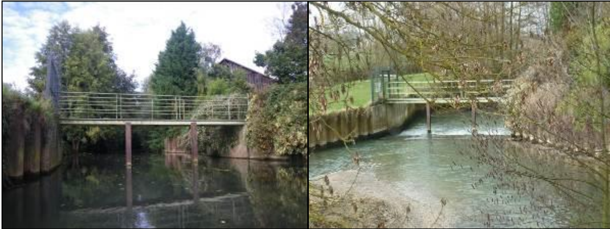
Photo 13 : Ouvrage D3 de Pontmoulin, permettant la mise en place de batardeaux en crue (Moulin de l'Arche régulant et ouvert)
